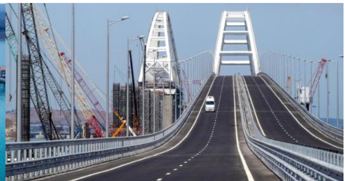
Podul Crimeea, zona auto finalizată și zona CF - în construcție
